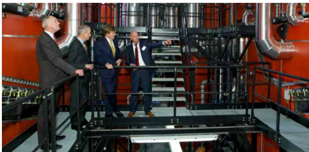
Koning Willem-Alexander krijgt een rondleiding in de BioWarmteCentrale.
